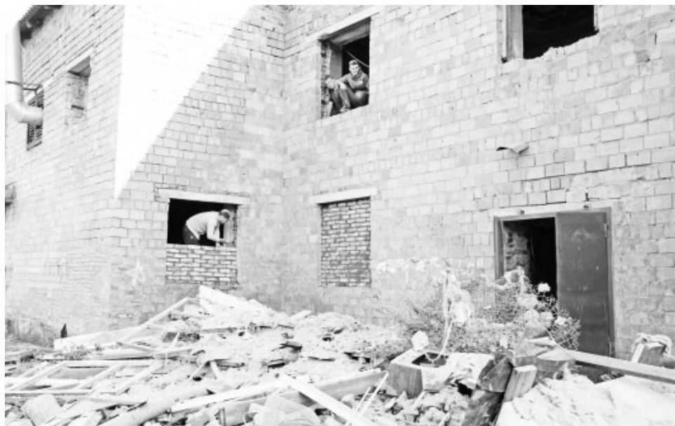
В здании бывшей бани кипит работа. Новые хозяева проводят серьёзную реконструкцию
