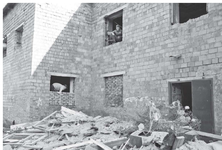
Ещё осенью здесь были груды строительного мусора, из окон летели обломки кирпича, сновали рабочие, подъезжали грузовые машины. А сегодня здание уже готовится к открытию
