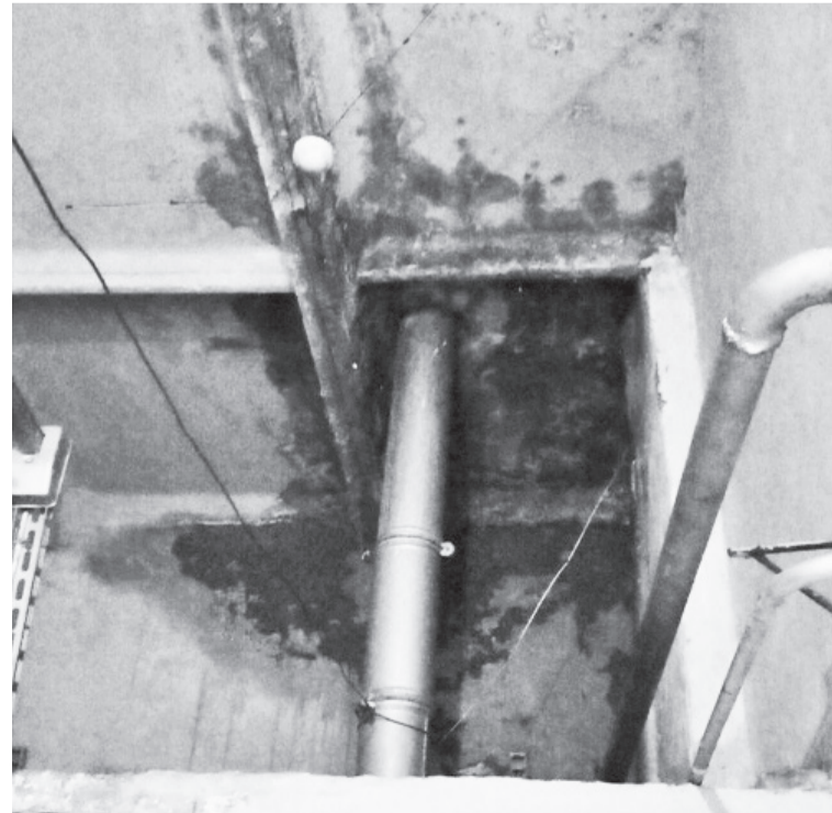
На здании копьёвской насосной станции протекла крыша. Приборы пришлось укрывать полиэтиленом
