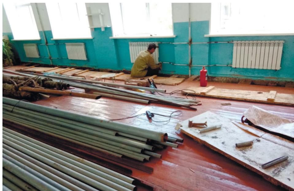
Полная замена системы отопления в Новомарьясовской СОШ-И
