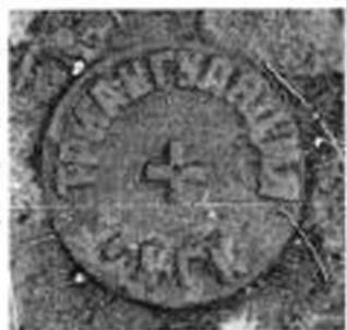
**Геодезические пункты** являются элементом геодезической сети, которая служит геодезической основой для производства геодезических, картографических и кадастровых работ.
