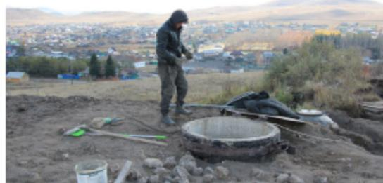
На этой неделе будут завершены капитальный ремонт и реконструкция первой накопительной ёмкости п. Копьево. Ёмкость стала выше на 1,5 метра и, соответственно, станет вмещать воды на 80 тонн больше - это улучшит напор воды в системе водоснабжения посёлка, особенно на отдалённых от водозабора улицах: Энергетиков, Южной, Степной и других. Ещё предстоит гидравлические испытания, а затем первая ёмкость будет введена в эксплуатацию.
