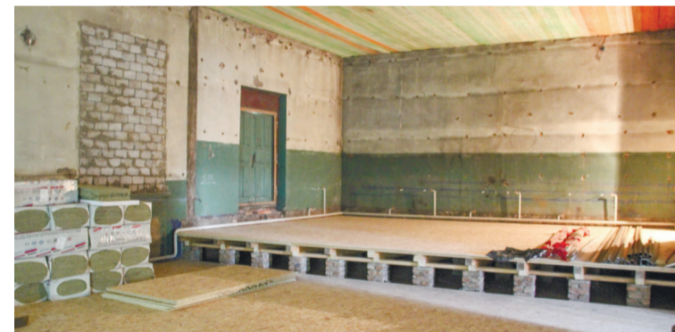
Ремонт в зрительном зале
