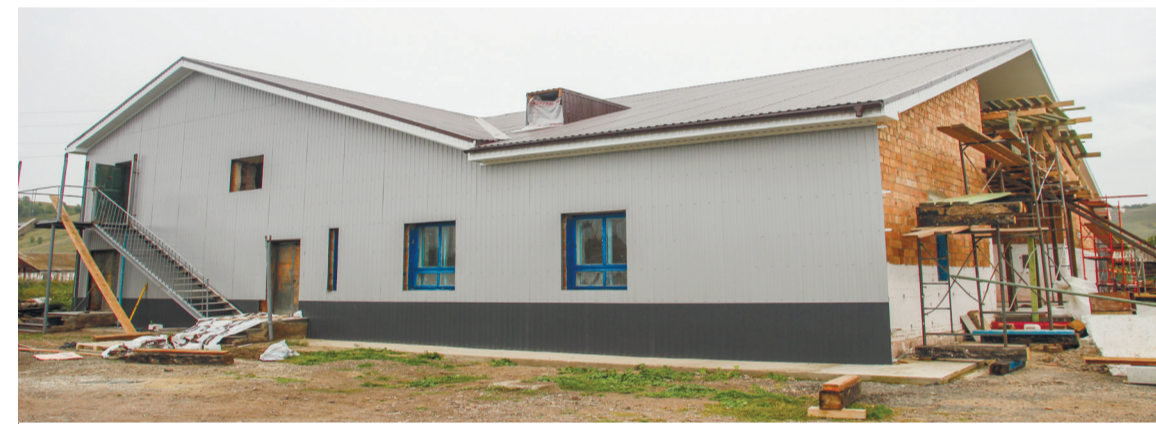
Снаружи здание обшивается профлистом
