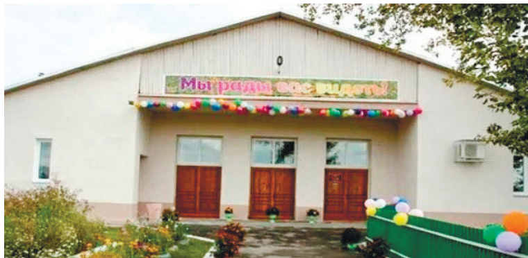
Здание Кобяковского СДК
